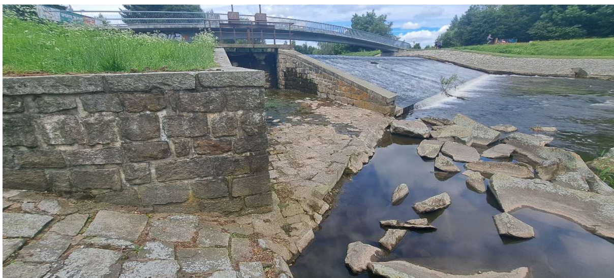
10. Ukončovací práh štěrkové propusti
