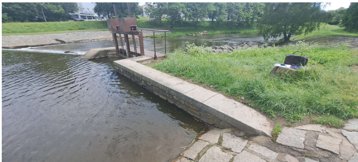
1. Zavázání opěrné zď do pravého břehu
